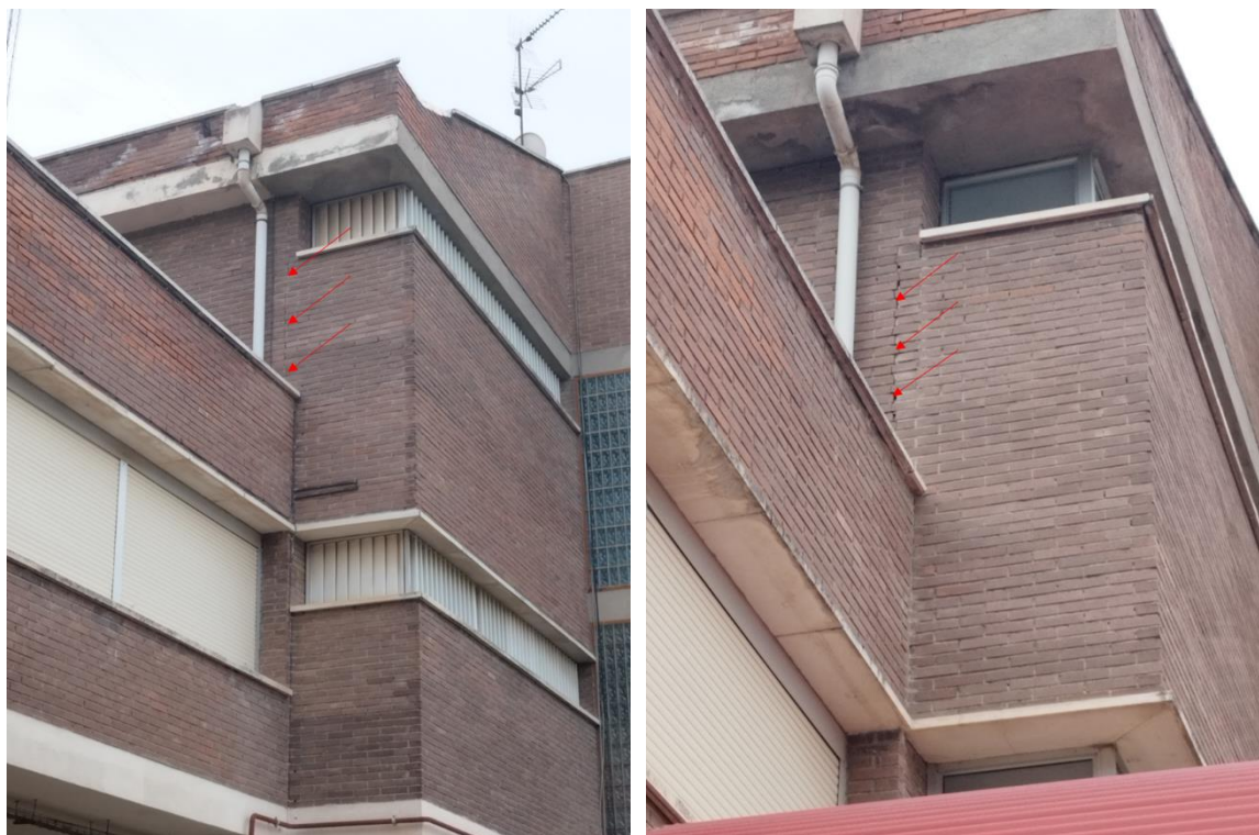
Figura 5. Fisuras en fachadas análogas a las que son objeto de consulta.
