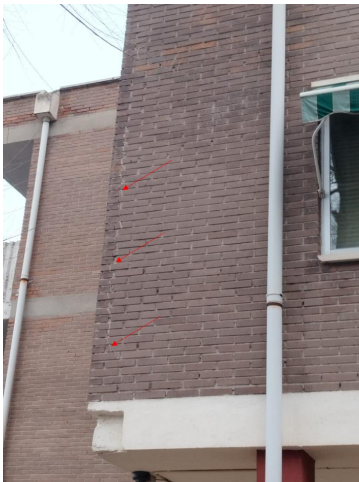
Figura 7. Fisura en la esquina de la fachada opuesta a la de la posición de las fisuras objeto de estudio.
