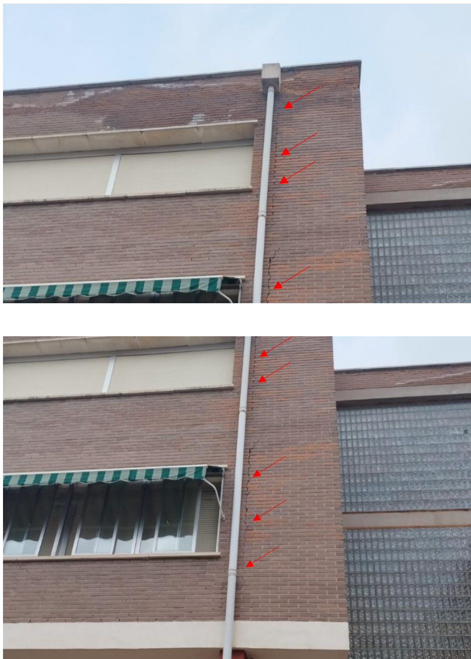
Figura 2. Vistas de detalle de las fisuras.
