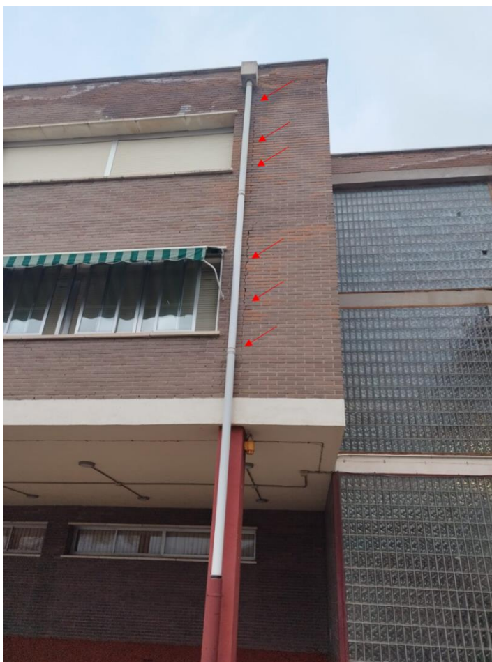
Figura 1. Fisuración en fachada objeto de estudio.
