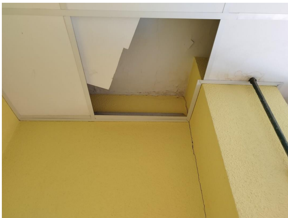
Figura 8. Vista de la fisuración en el encuentro de la hoja interior del cerramiento con el soporte en planta primera.
